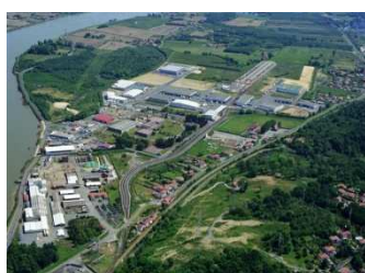
Plate-forme logistique multimodale de Bayonne
